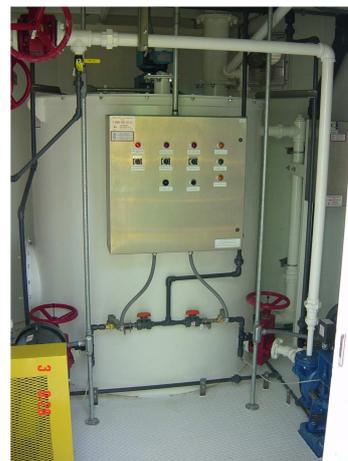
El mezclador estará energizado siempre, cuando haya líquido dentro del estanque de lechada. Las paletas impulsoras deben permanecer dentro del líquido todo el tiempo durante la operación. Seguir la operación con las paletas impulsoras fuera del líquido ó expuestos parcialmente fuera del líquido puede causar daños a la unidad.
